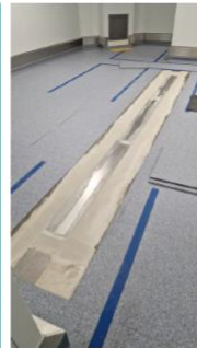
UR 1 - Reprise des joints de dilatation
